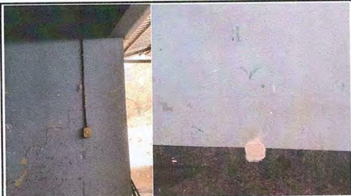
Foto1: CABLE, APAGADORES Y TOMACORRIENTES TODA LA INSTALACIÓN EN MAL ESTADO
